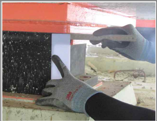
P6 교량받침 이동량 측정(영천)
