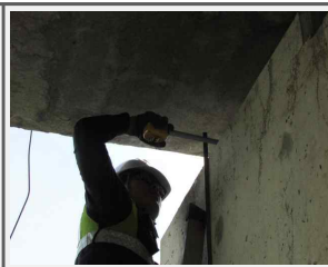
교대 연단거리 측정 (영천)
