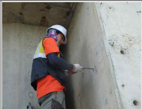
하부구조 탄산화깊이 측정
