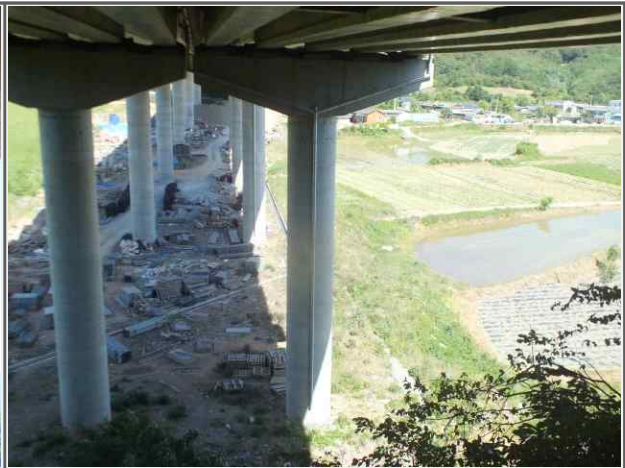
내 용 산성교(영천) 교각
