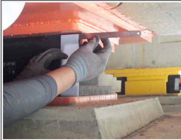
A1 교량받침 이동량 측정(상주)
