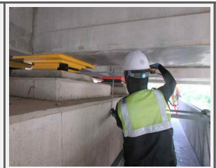
교각 연단거리 측정 (영천)
