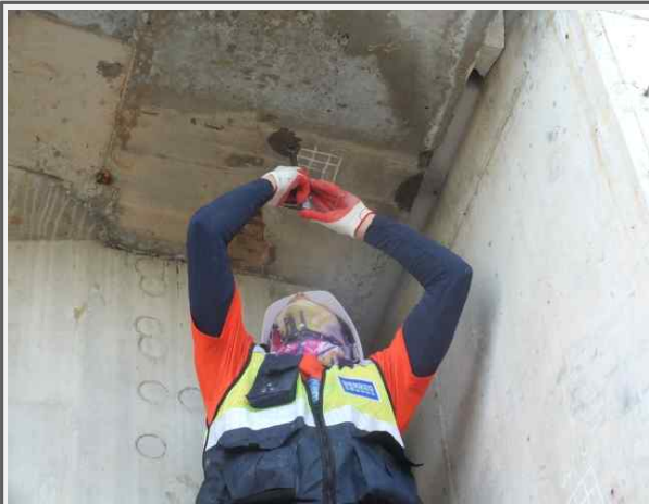
상부구조 탄산화깊이 측정
