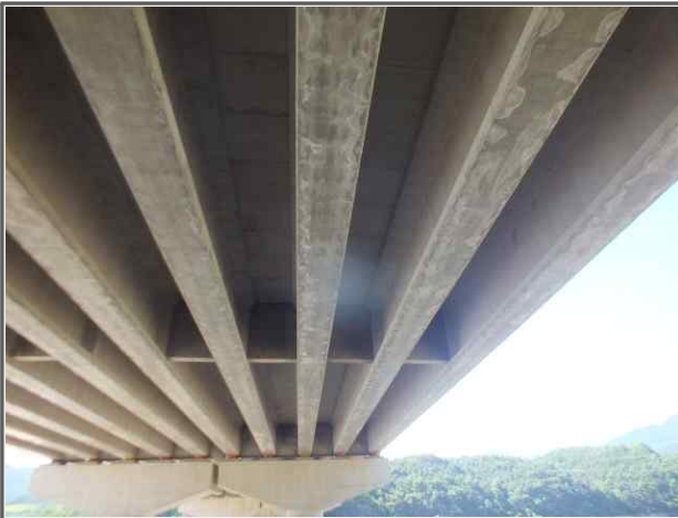
내 용 산성교(영천) 하부
