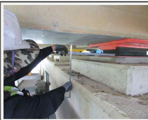
교각 연단거리 측정 (상주)
