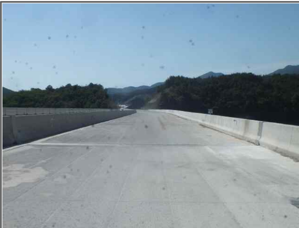
내 용 산성교(영천) 상부
