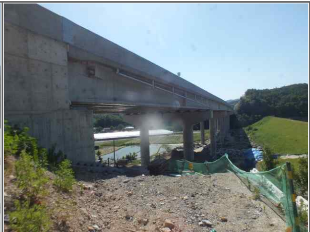
내 용 산성교(영천) 측면
